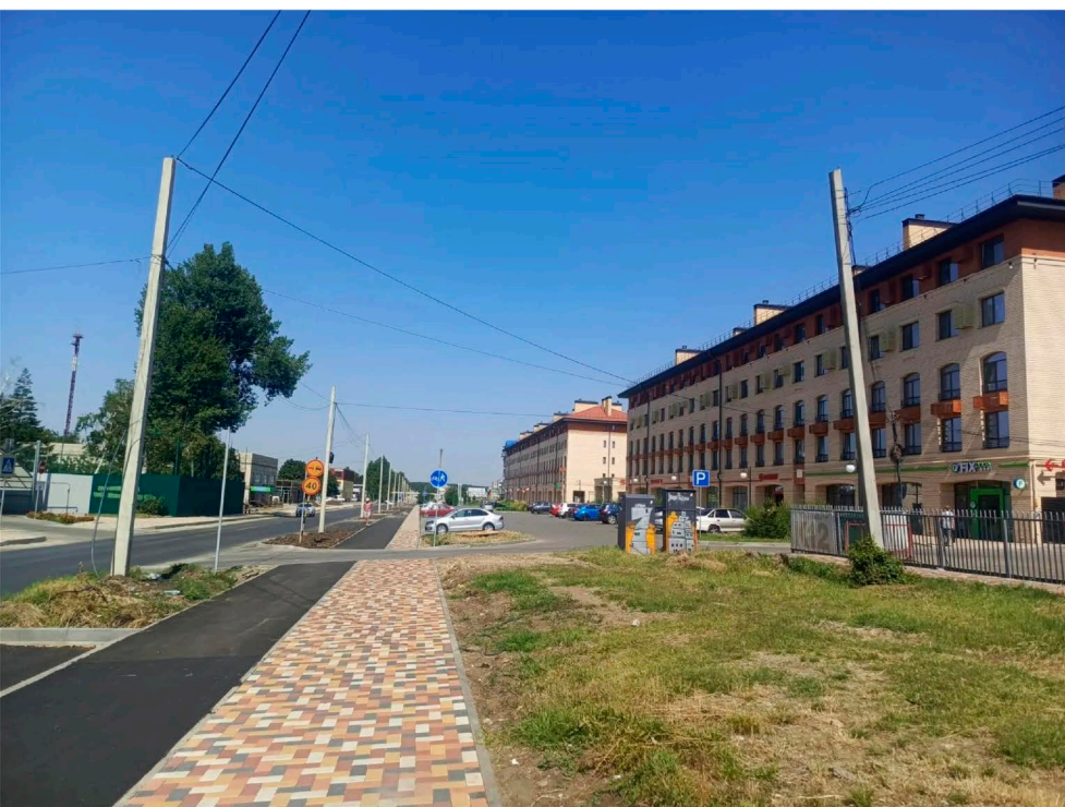
Устройство линии наружного освещения по ул. Назара Енина
